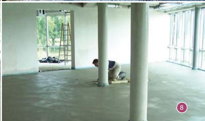
Les images ci-dessus montrent les principales séquences de la pose sous chape en général des résilients DAMTEC®. Important: Voir les guides respectifs à la pose des différents produits DAMTEC® pour avoir les instructions complètes et détaillées. Les versions actuelles des instructions de pose des sous-couches DAMTEC® sont disponibles sur [www.kraiburg-relastec.com/damtec](http://www.kraiburg-relastec.com/damtec).
